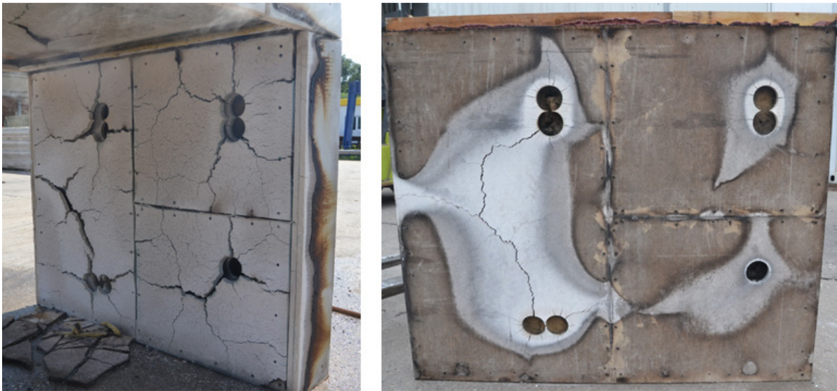
Abbildung 3-14 Versuch V2a nach dem Herausheben aus dem Prüfofen (links) und dem Abnehmen der zweiten Bekleidungslage des großen Wandbauteils (rechts)
