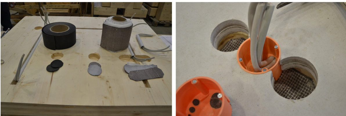
Abbildung 3-21 Einbau von intumeszierenden Brandschutzmaterialien
