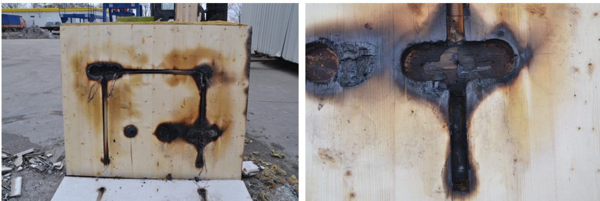
Abbildung 3-24 Wandelement nach Entfernen der Bekleidung, rechts Detailaufnahme
