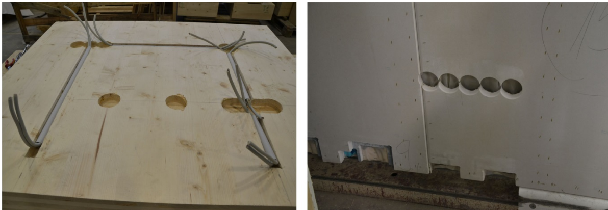
Abbildung 2-12 unzulässige Bauweisen: Installation in Aussparungen im Brettsperrholz, Mehrfach-Elektroinstallationsdosen, Einbau von Elektrodosen zu dicht am Holzständer
