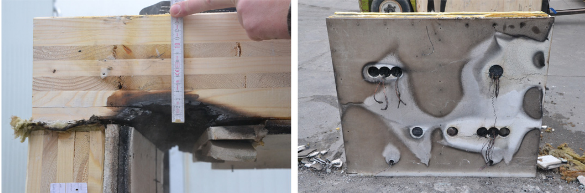
Abbildung 3-23 Begutachtung nach dem Versuch, Wand/Deckenfuge und Wandelement nach Entfernen der zweiten Bekleidungsstufe
