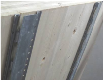
Bild A.3: Massivholzschale des Prüfkörpers IWT 2 bzw. TW 2, Montagezustand vor dem Anbringen der Gipskartonbeplankungen
